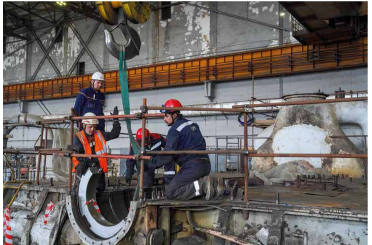
Монтаж оборудования в турбинном цехе на ТЭЦ-10 (Ангарск) Фото: Дмитрий Дмитриев
